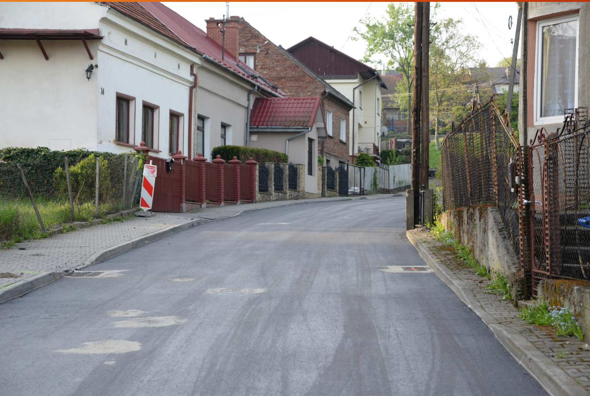
UL. WĘGIERSKA - WYKONANIE NAKŁADKI ASFALTOWEJ
