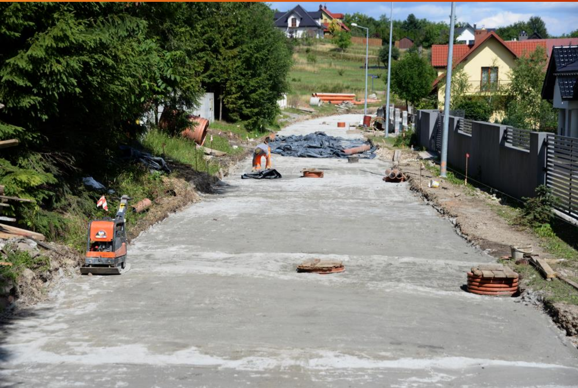
UL. FRYCZA - BUDOWA DROGI Z ODWODNIENIEM
